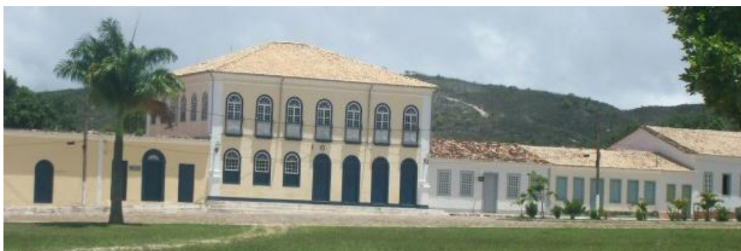
Figura 04 – Endereço da casa fundição Rio Contas. Fonte: Do autor, abril, 2016.
